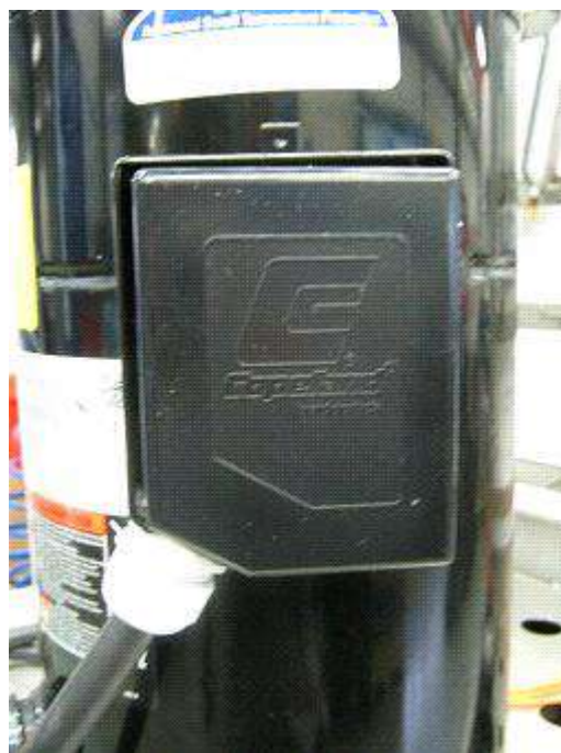
Рис 10: Правильное электрическое подключение клеммной коробки IP21 с помощью кабельных муфт
