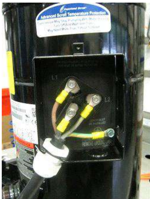
Рис 10: Правильное электрическое подключение клеммной коробки IP21 с помощью кабельных муфт
