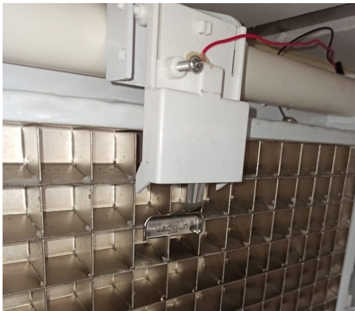
Рис1. Датчик уровня наполнения льда на решетке. Решетка охлаждения
